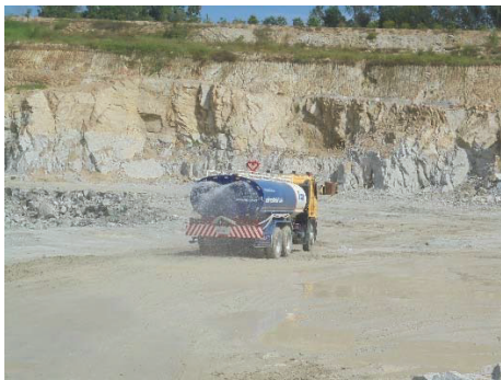
รูปที่ 2-25: การฉีดพรมน้ำบริเวณพื้นที่หน้าเหมือง
