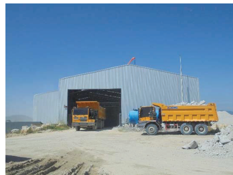
รูปที่ 2-14: อาคารปิดคลุม 3 ด้าน และหลังคา สำหรับเครื่องบดชุดแรก ยังรับหินใหญ่
