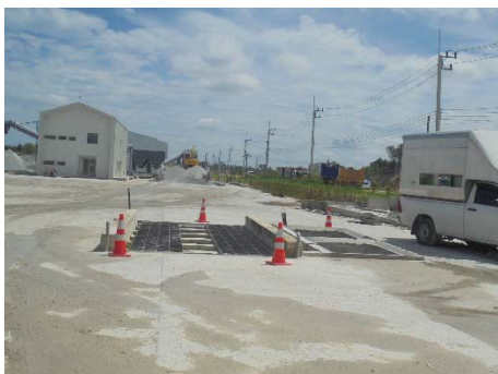
รูปที่ 2-21: ระบบลานล้างล้อรถยนต์ก่อนออกนอกโรงโม่หิน
