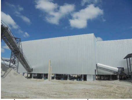
รูปที่ 2-15: อาคารปิดคลุมเครื่องจักรอุปกรณ์เครื่องบดชุดที่ 2 และเครื่องบดชุดที่ 3
